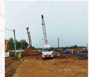
Progress Pembangunan Exit Tol Kadusirung
